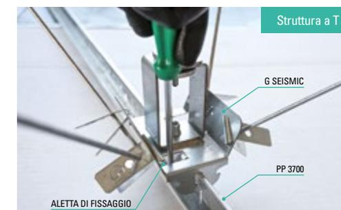
Montare ad infilo il kit antisismico tramite l'apposito gancio sul profilo a T, a seguire abbassare le alette.
