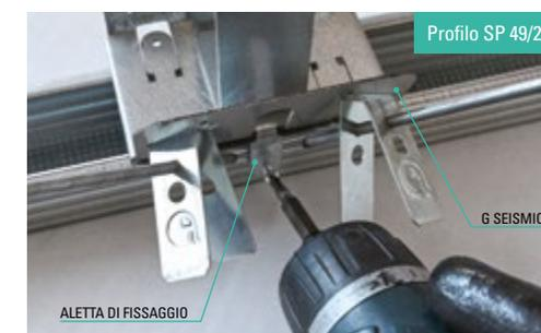
Procedere con il fissaggio del kit antisismico al profilo con l'ausilio di viti auto perforanti.
