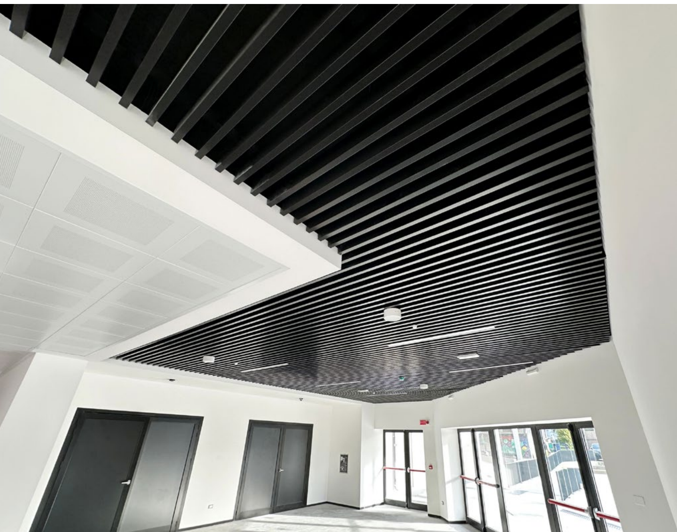
Doghe Q-Baffle , colore preverniciato nero, acciaio zincato (DX51DZ), finitura liscia.
