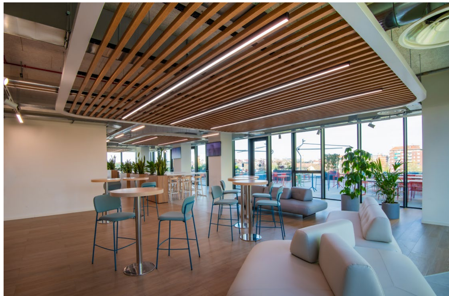
Doghe Q-Baffle con finitura legno installati con passo variabile su traversina TR15.
