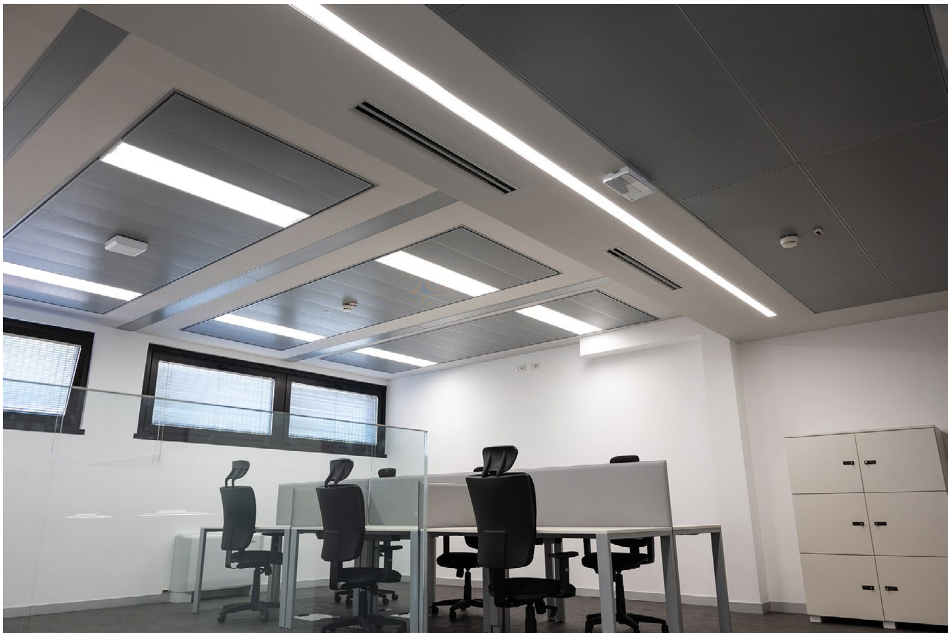
Vert Semi Visio 300x1200 mm e Vert Occulto 600x1800 mm in acciaio zincato post-verniciati silver, microforati e con illuminazione integrata.
