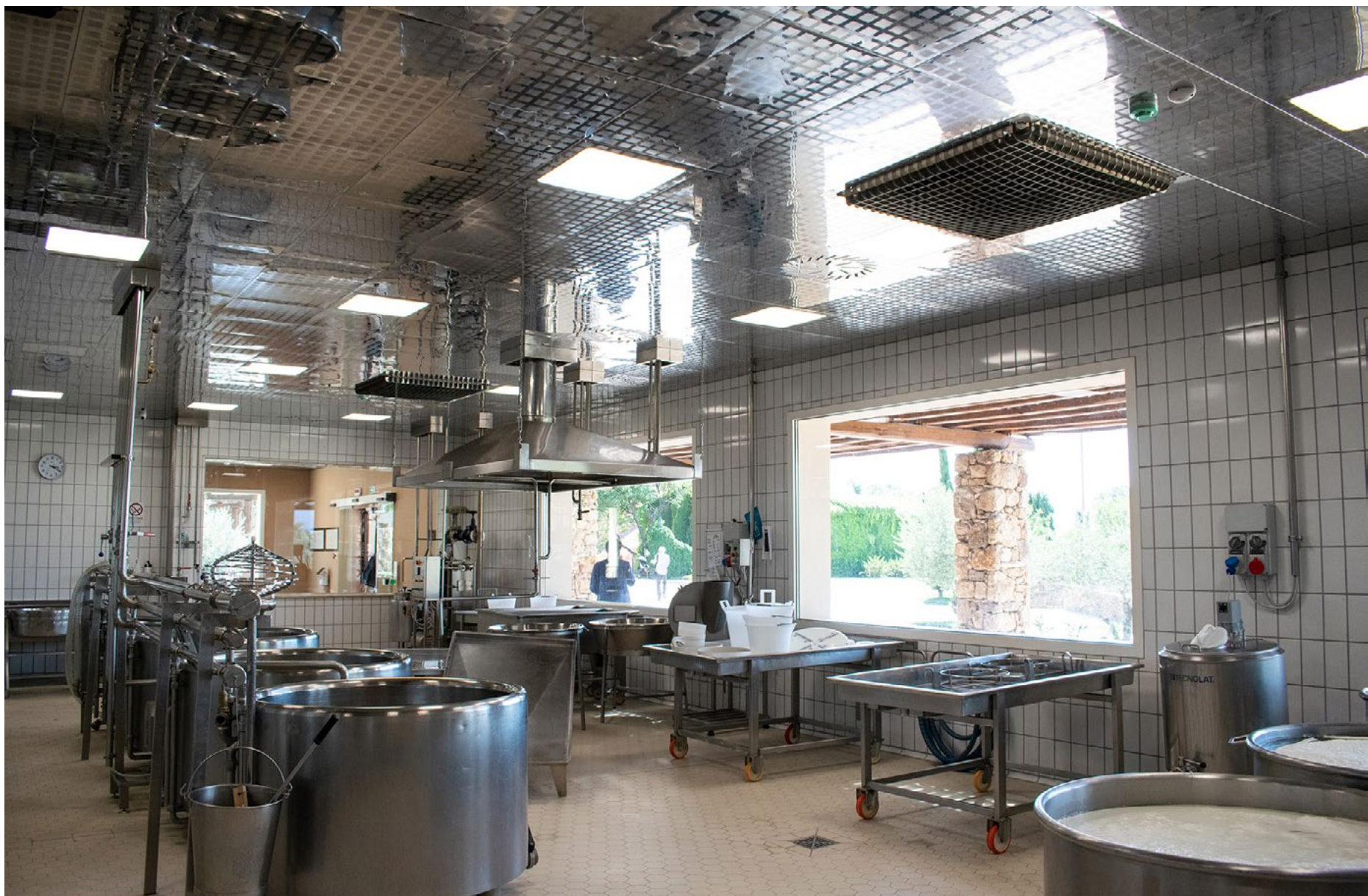
Vert Lab in acciaio inox con finitura mista, che prevede una superficie lucida e satinata con effetto quadrato.
