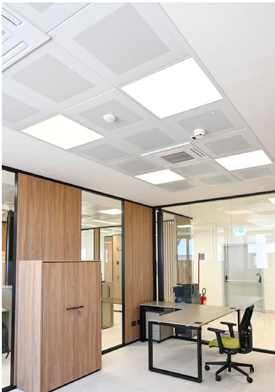
Vert Occulto 600x600 mm in acciaio con foratura diagonale tipo FD2 e velo acustico TNT.
